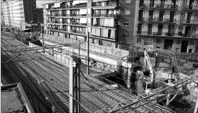
Obres del TAV a l'entrada a la ciutat de Barcelona pel barri de Sants // FOTO: Albert Garcia
